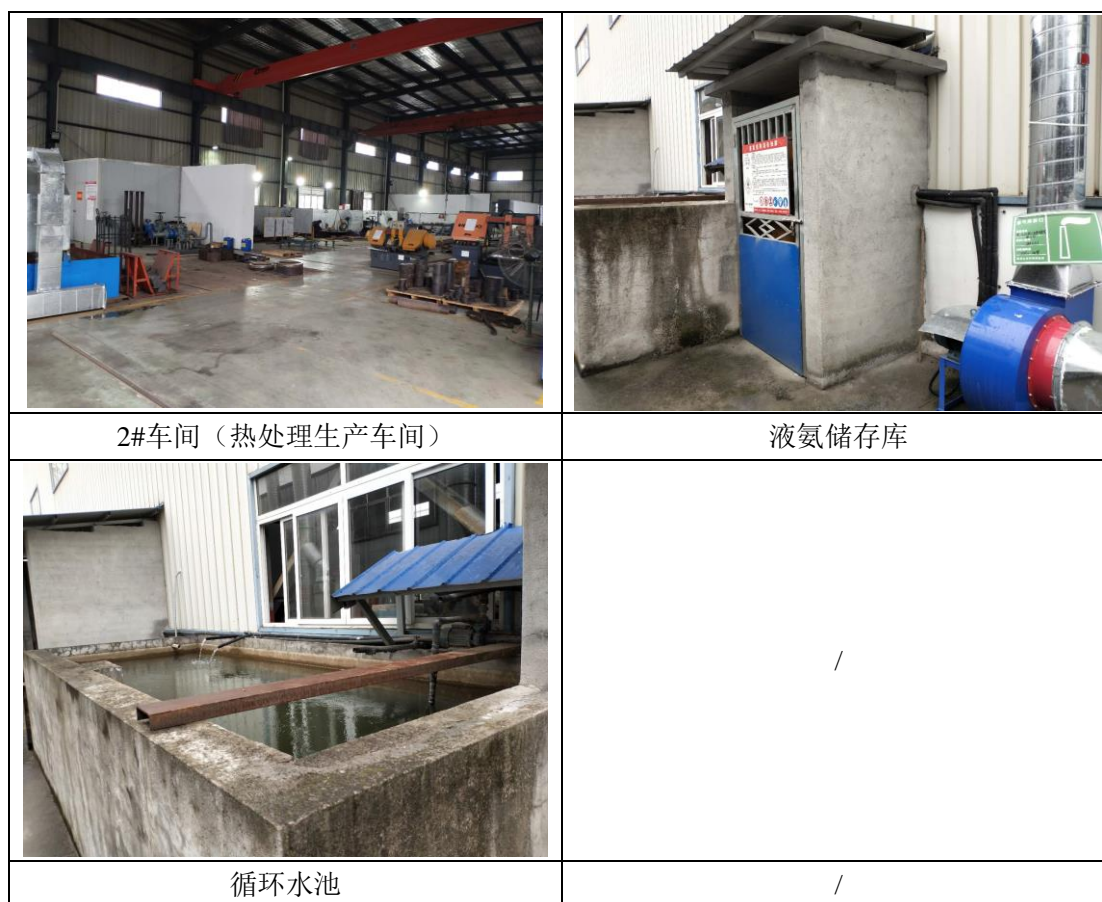
图 2-1 扩建项目主体工程建设情况
